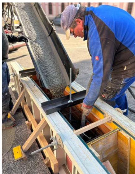
Betonierarbeiten am Carport
